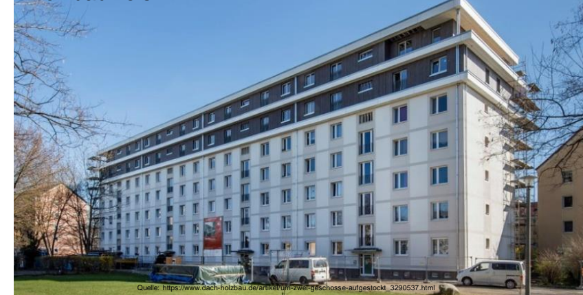
Mehrfamilienhaus in Dresden mit Dachaufstockung in Holzbauweise
